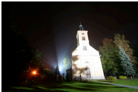
Příklad nevhodně nasvíceného kostela, světlomety míří mimo budovu (zdroj: svetelneznecistení.cz).
